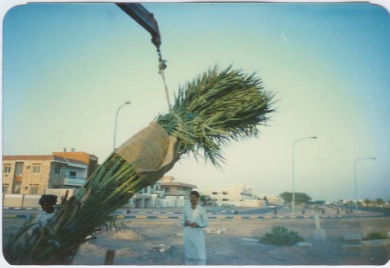
شكل (٥-٢٣) آلة رافعة لوضع أشجار النخيل البالغة بالجور المعدة مسبقاً
