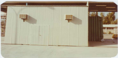
شكل (٣-١٢) غرفة تبخير جاهزة مستطيلة الشكل مع كافة الأجهزة الضرورية لعملية التبخير
