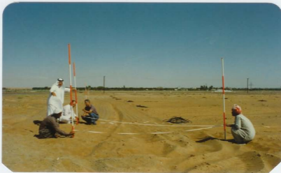
شكل (٢٧-٥) تخطيط بستان النخيل بالطريقة الرباعية باستخدام نظرية المثلث القائم الزاوية
